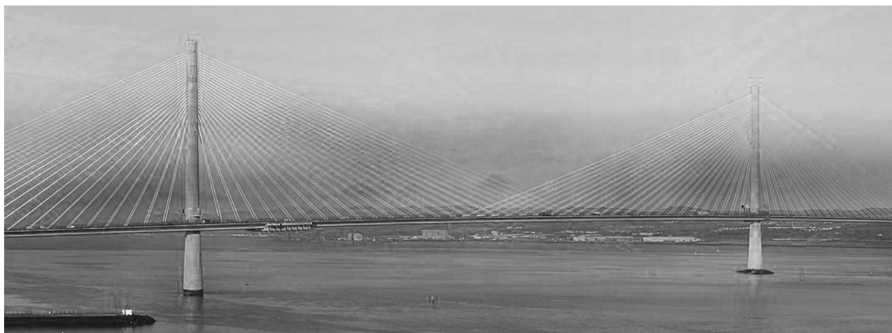
Figura 2. Queensferry Crossing Bridge, ubicado en Inglaterra y resuelto mediante el entrecruzamiento de cables en 2017.
